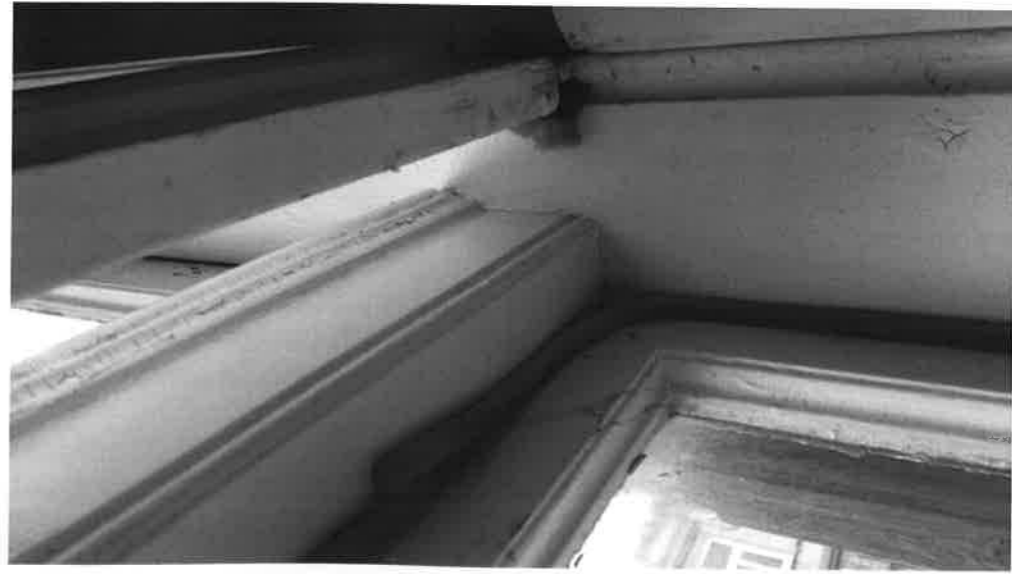
2017.g. janvārī fiksētās sākotnējo logu detaļas – šķērsis, iekšējo vērtnu aizvērējs un ārējo vērtnu spanjolete
