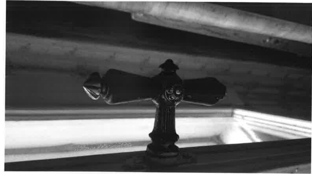
2017.g. janvārī fiksētās sākotnējo logu detaļas – šķērsis, iekšējo vērtnu aizvērējs un ārējo vērtnu spanjolete
